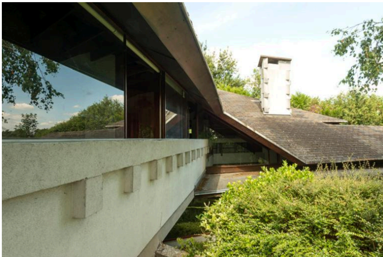
Vue prise depuis l'intérieur de la passerelle.
