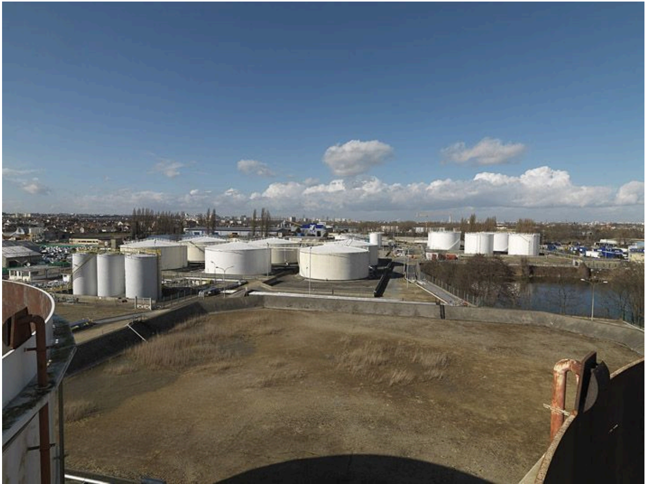
Villeneuve-le-Roi, dépôt pétrolier. Vue des alentours depuis le haut d'un réservoir.
