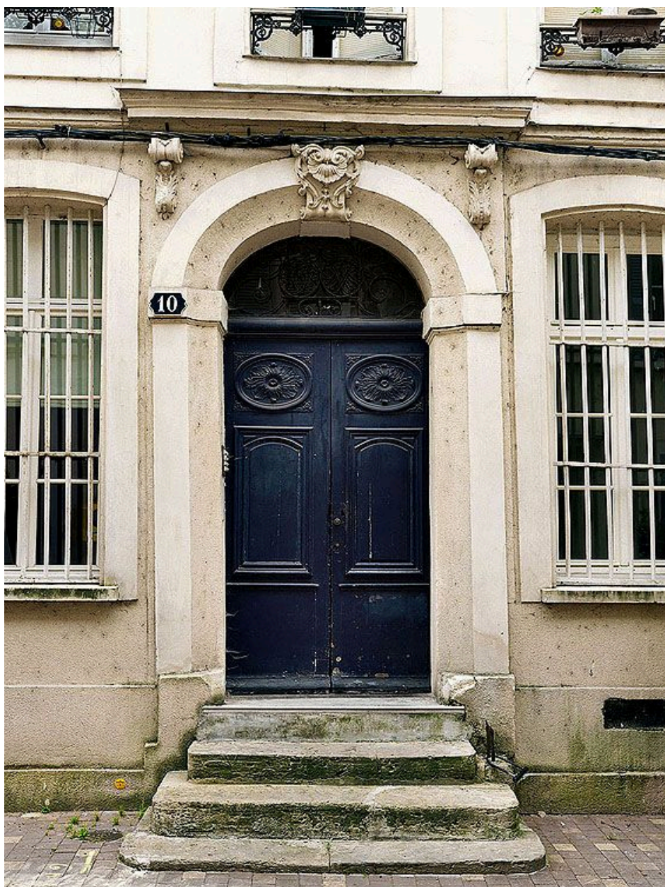
La porte d'entrée du 10, rue saint-Christophe.
