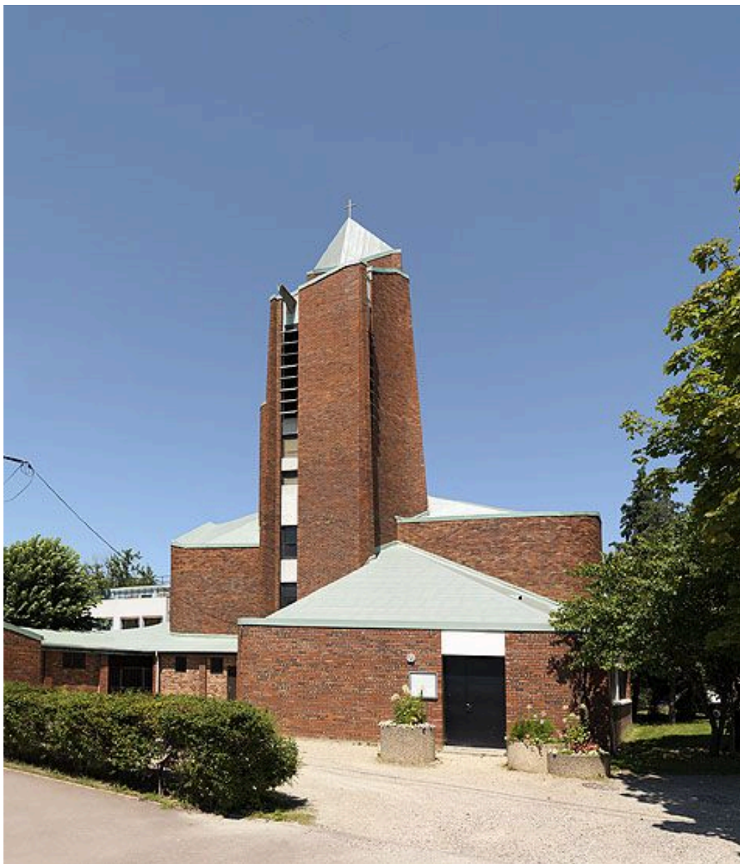
95, Garges-les-Gonnesse, église paroissiale Sainte-Geneviève, rue du Colonel-Fabien. Vue d'ensemble de l'église.
