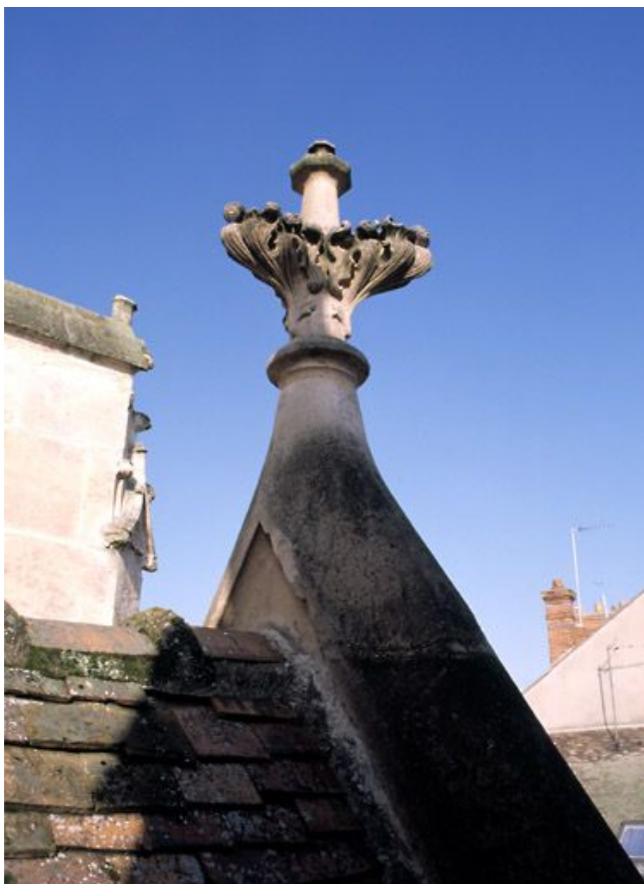
Couronnement d'un pignon, vu depuis la terrasse du collatéral nord.
