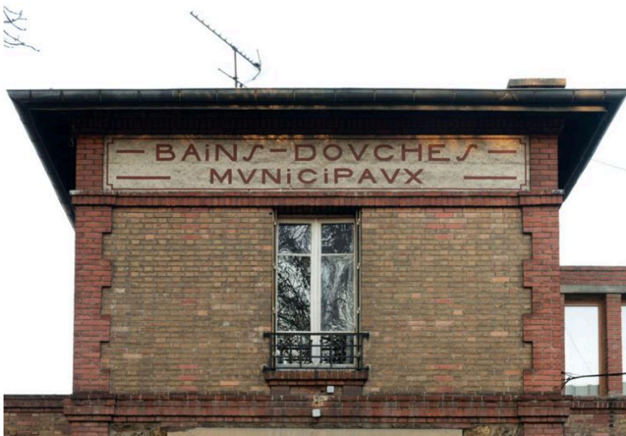
Détail de l'inscription "Bains-douches municipaux" en mosaïque de grès cérame, couronnant l'établissement.
