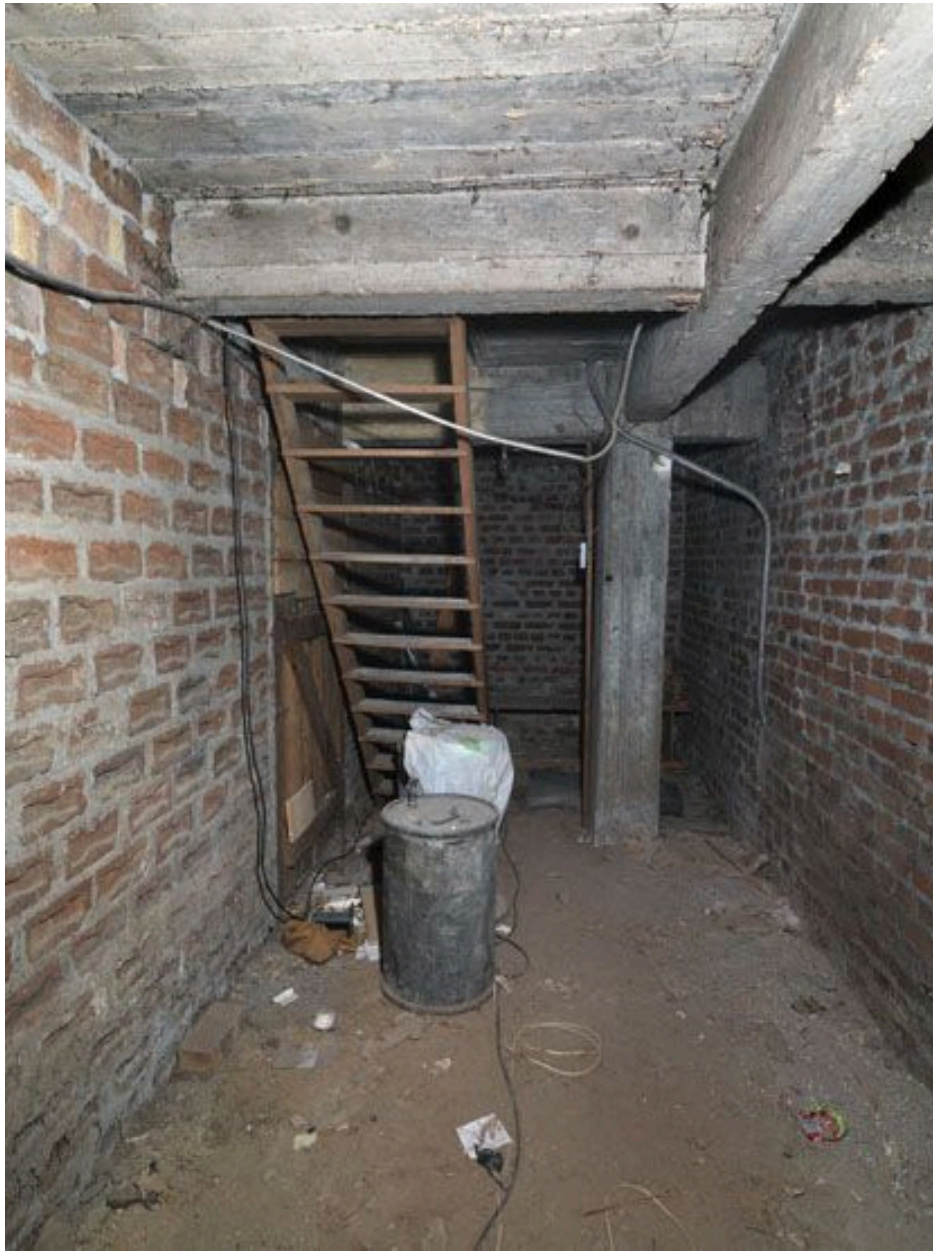
Vue générale de la première cave prison.
