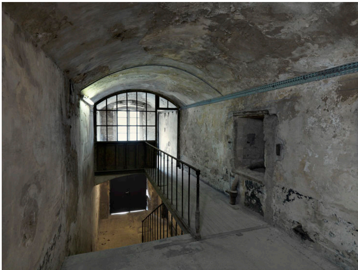
Vue intérieure de la caserne : l'escalier ouest, vu du palier à l'étage.
