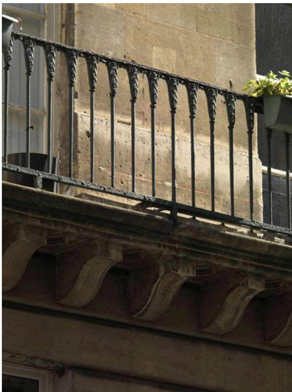
Détail du balcon de la façade sur rue.
