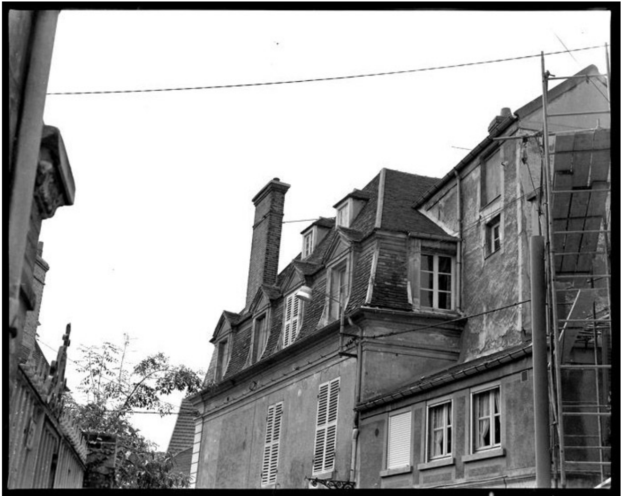
Maison, Gambetta (rue) 6. Vue d'ensemble de la toiture.
