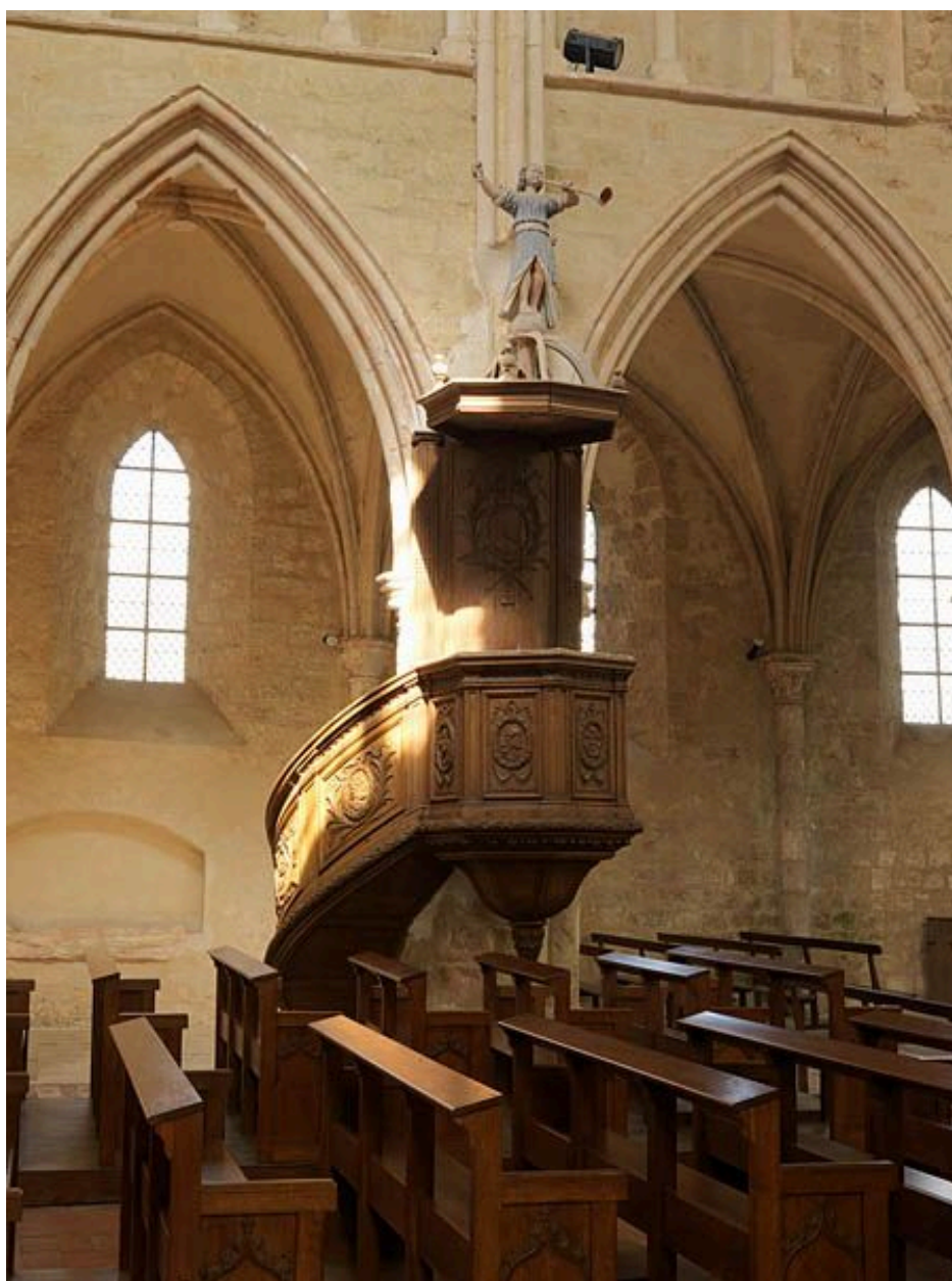
Vue d'ensemble, depuis le sud.
