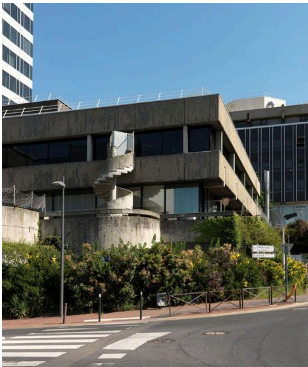
Vue d'un escalier hélicoidal à l'angle de la rue de la Préfecture.
