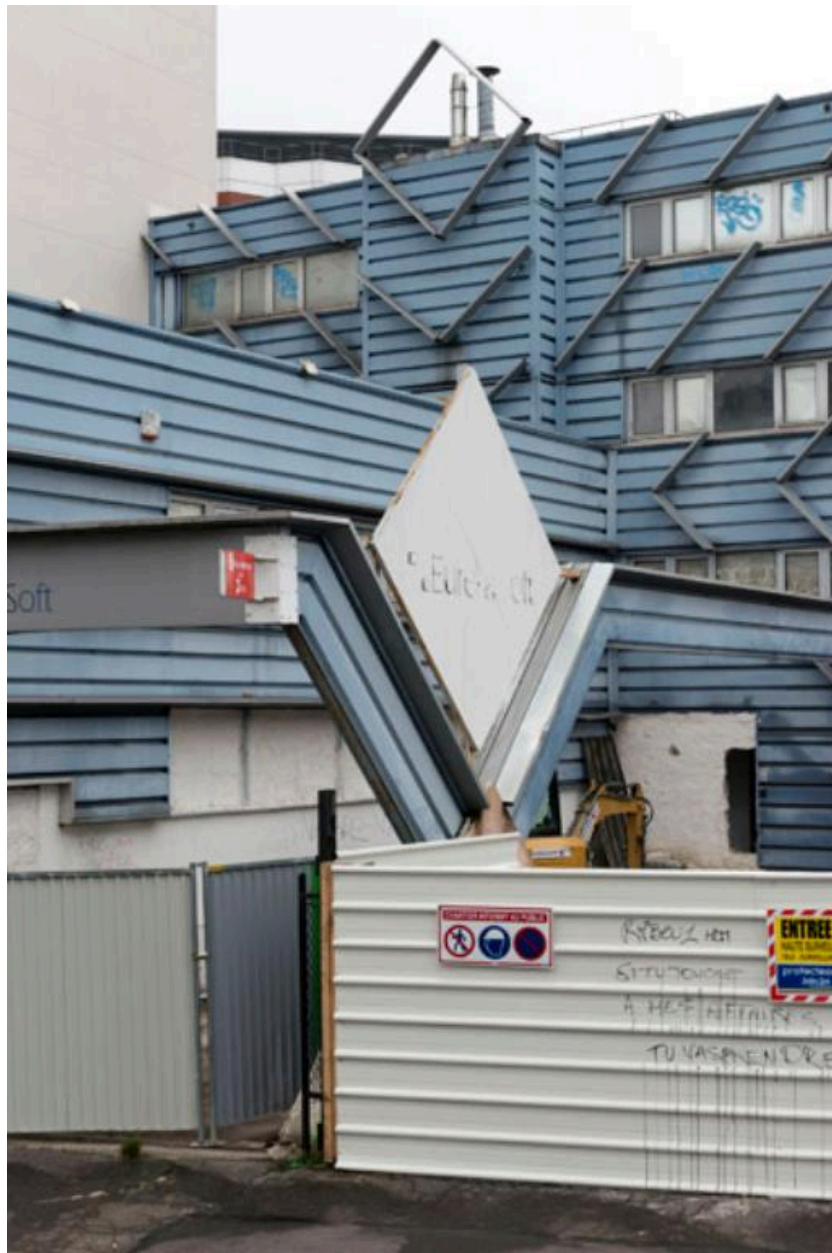
Détail de la façade latérale, depuis la rue.
