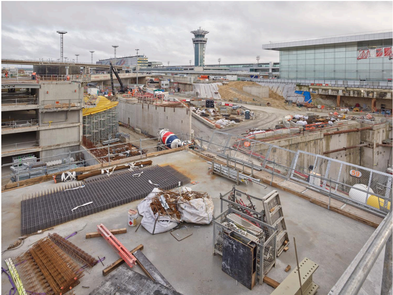
16/12/2020, chantier de construction de la station de métro Aéroport d'Orly (lignes 14 et 18) vu depuis le nord ouest.
