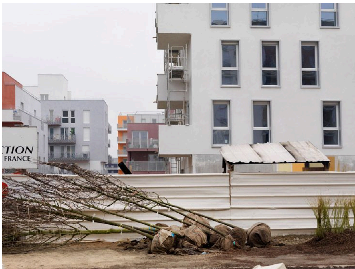
Massy. Quartier résidentiel Atlantis en construction.
