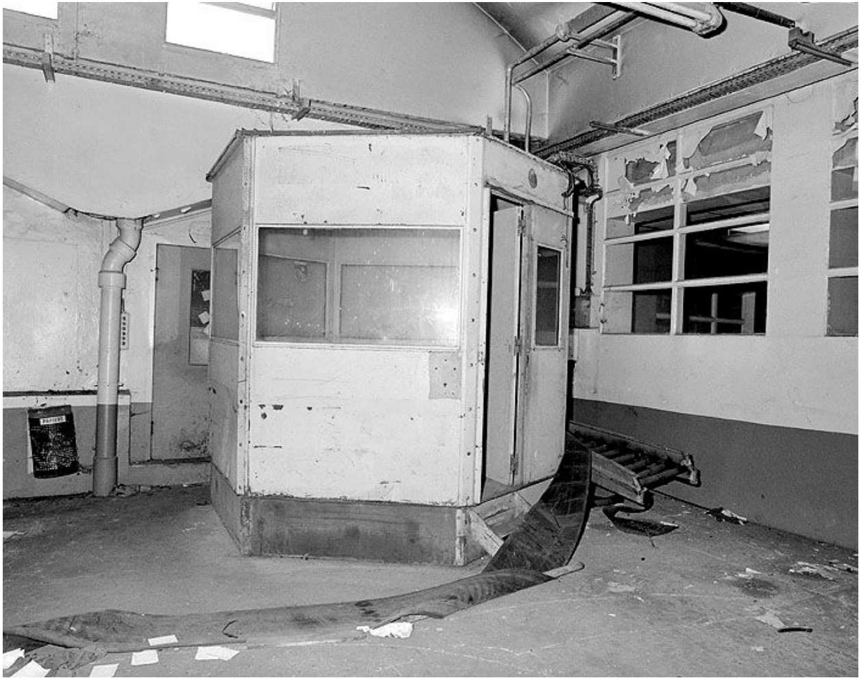
Le hall d'embouteillage : bureau de contremaître. Photographie avant destruction, 1989. (Ministère de la culture, Inventaire général. 89SG692X)
