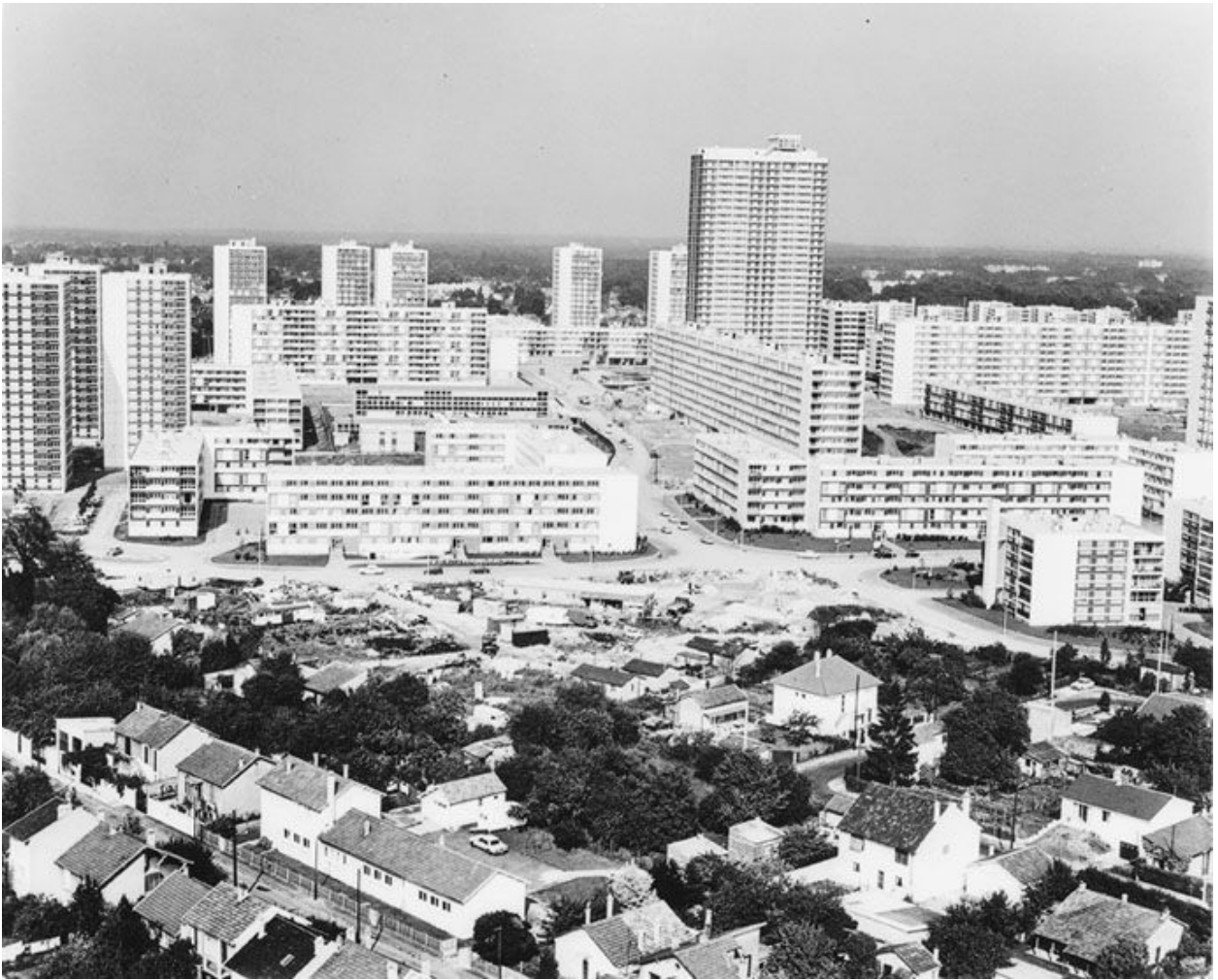
Vue aérienne du grand ensemble de Bois l'Abbé. Photographie, vers 1960. (AD Val-de-Marne)
