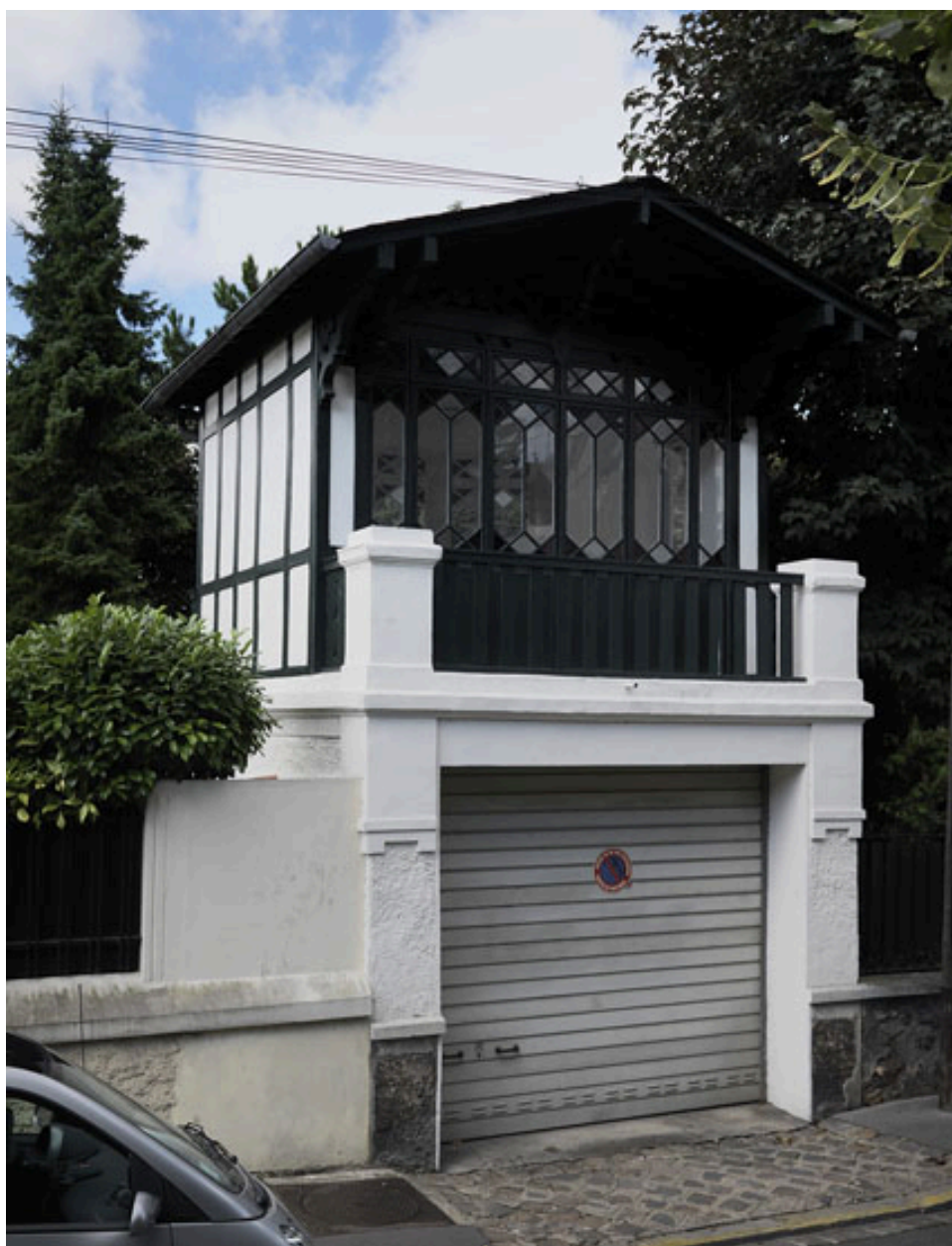
Vue d'un garage surmonté d'un atelier, 3 rue du Docteur Leray.
