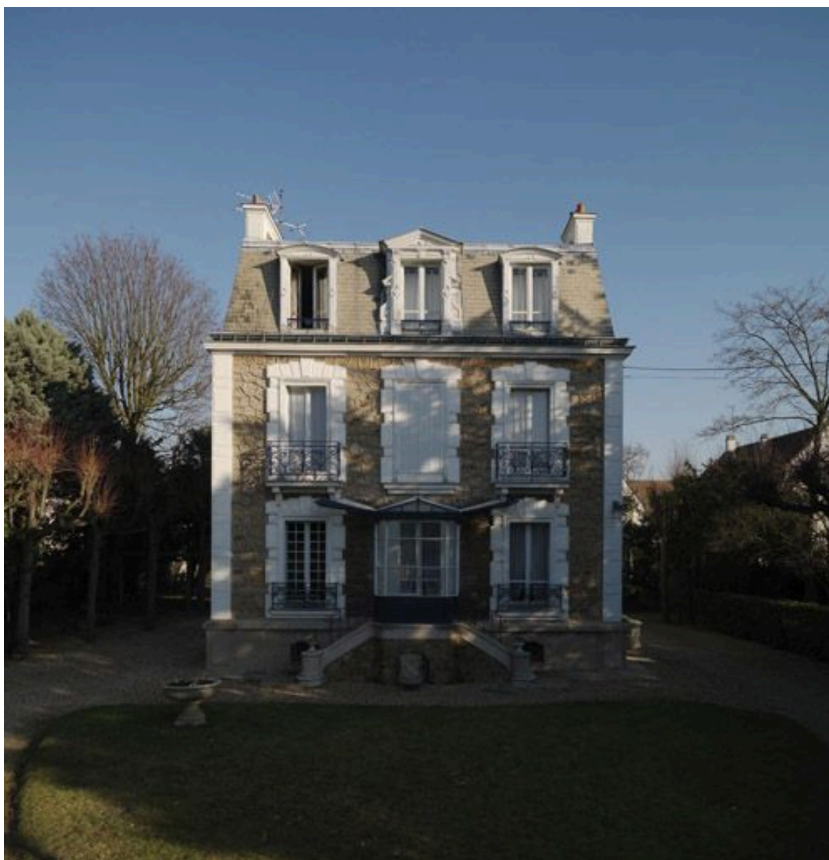
Vue d'ensemble de la maison, 44 avenue de Bellevue.
