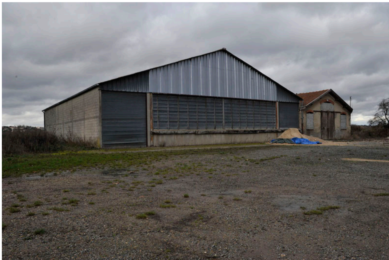
Achères, entrepôt agricole, chemin des Hautes-Plaines. Vue d'ensemble.
