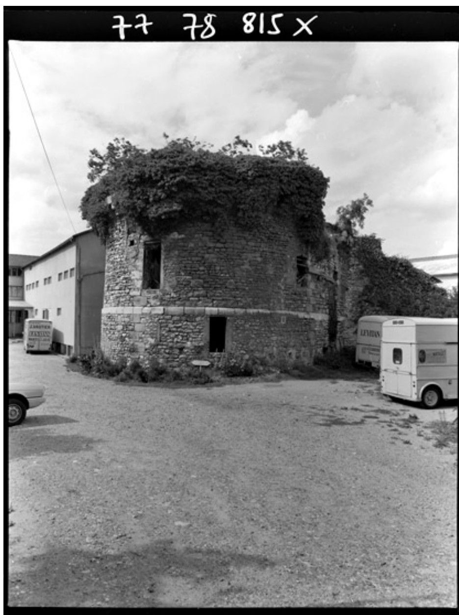
Vue de la tour Saint-Martin en 1977.
