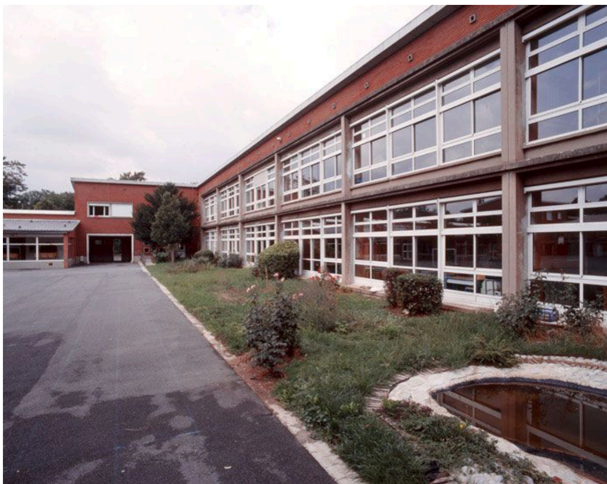
Groupe scolaire Joliot-Curie, rue Irène Joliot-Curie. Julien Heulot (architecte communal). Vue du bâtiment de classe, au fond les locaux administratifs.
