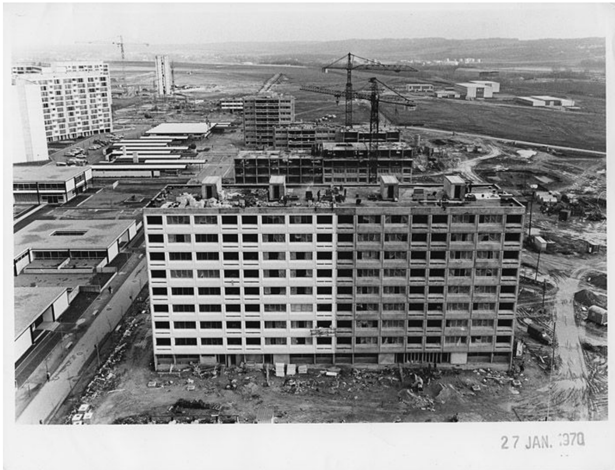
Chantier de la construction - Mise en place des grues sur rail et achèvement de l'élévation des barres de Beauval. Vue de l'école primaire et du collège Camus - 27 janvier 1970. (OPAC Meaux)
