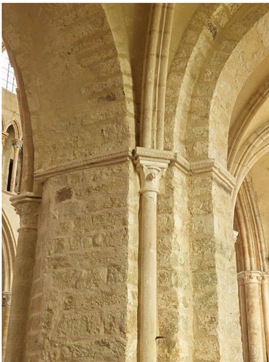
Détail d'un pilier de soutènement du clocher.
