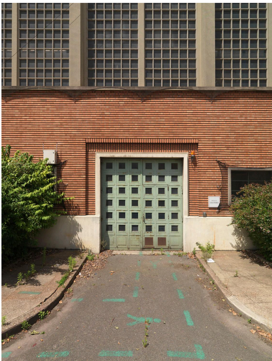
Site Sanofi. Vue de la portée d'entrée principale du bâtiment de la chaufferie.
