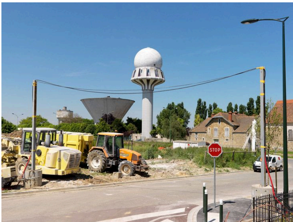
Palaiseau, rue Auguste Rodin. Radôme et château d'eau au débouché de la nouvelle rue Auguste Rodin.
