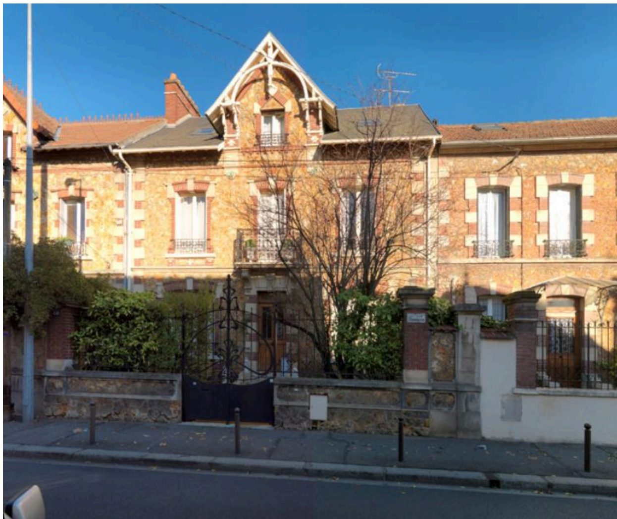
Vue de la façade principale et de la ferronnerie du portail.
