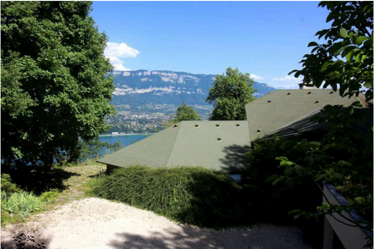
Vue rapprochée d'une partie de la toiture.
