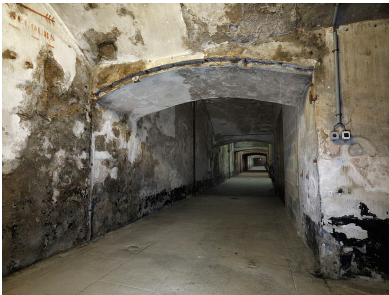
Vue intérieure de la caserne : le couloir du premier étage, vu depuis l'ouest.
