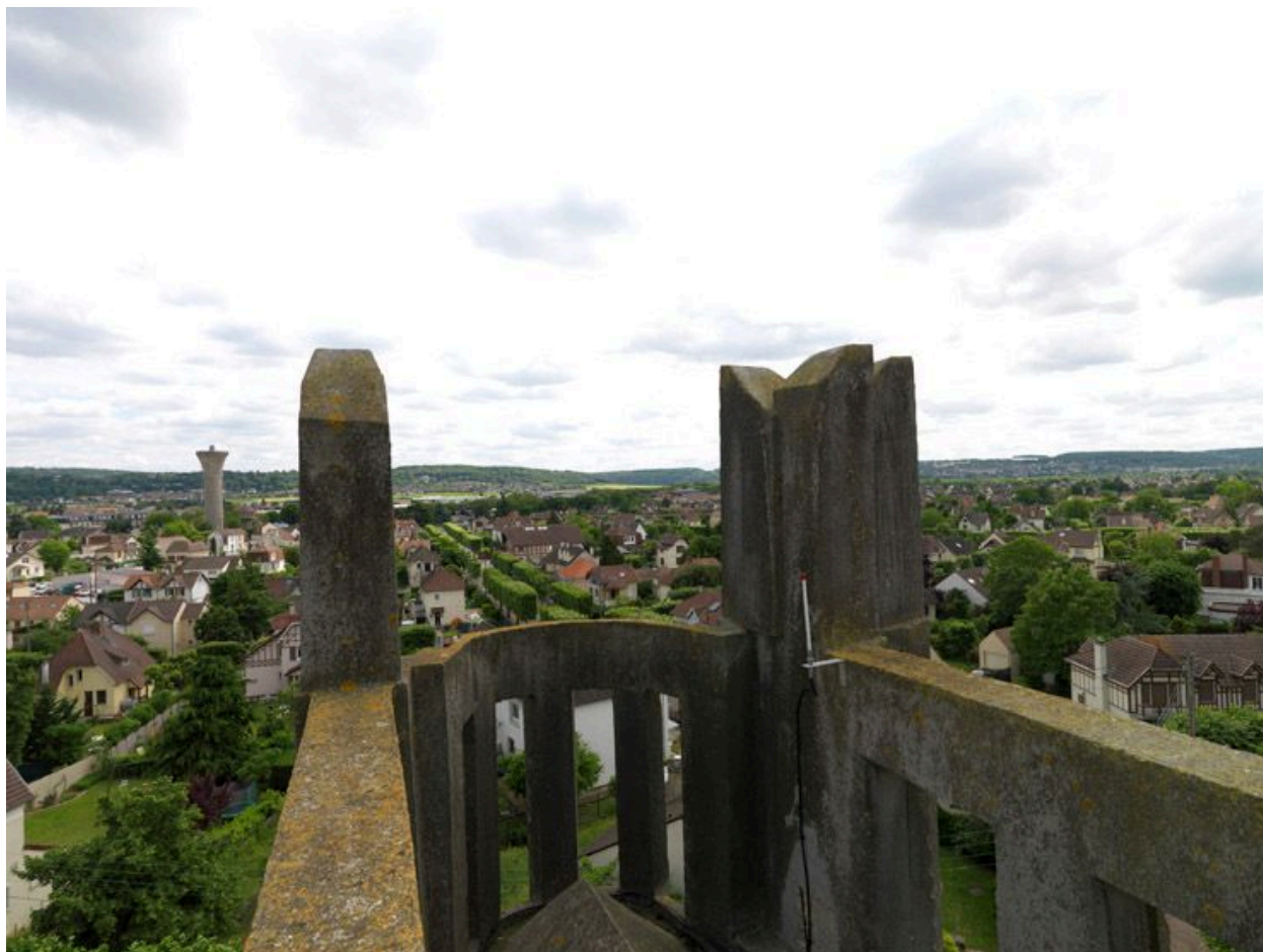
Garde-corps surmontant la tourelle de l'escalier de l'église.
