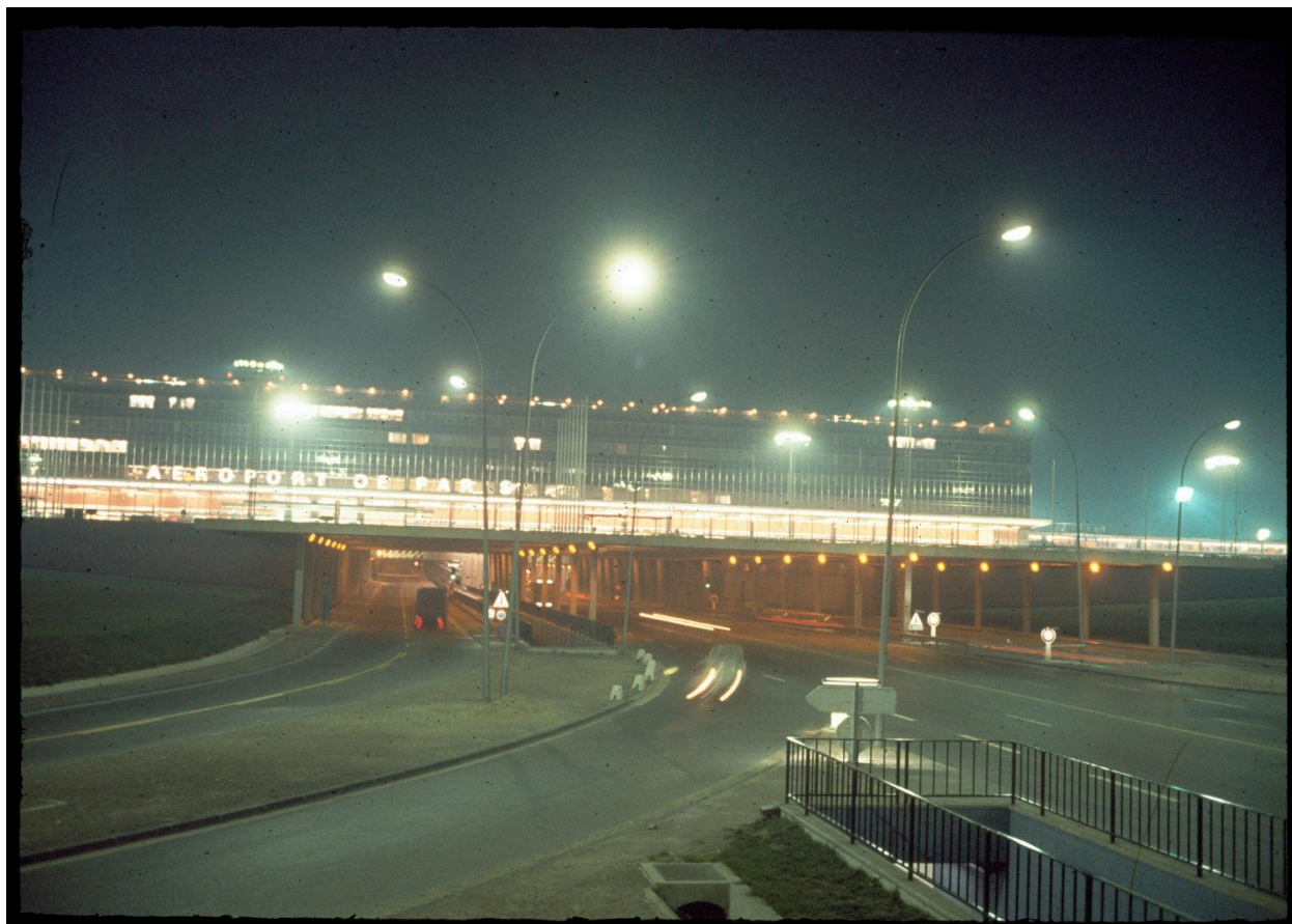
1961 1966, les Installations Terminales vues depuis le nord.
