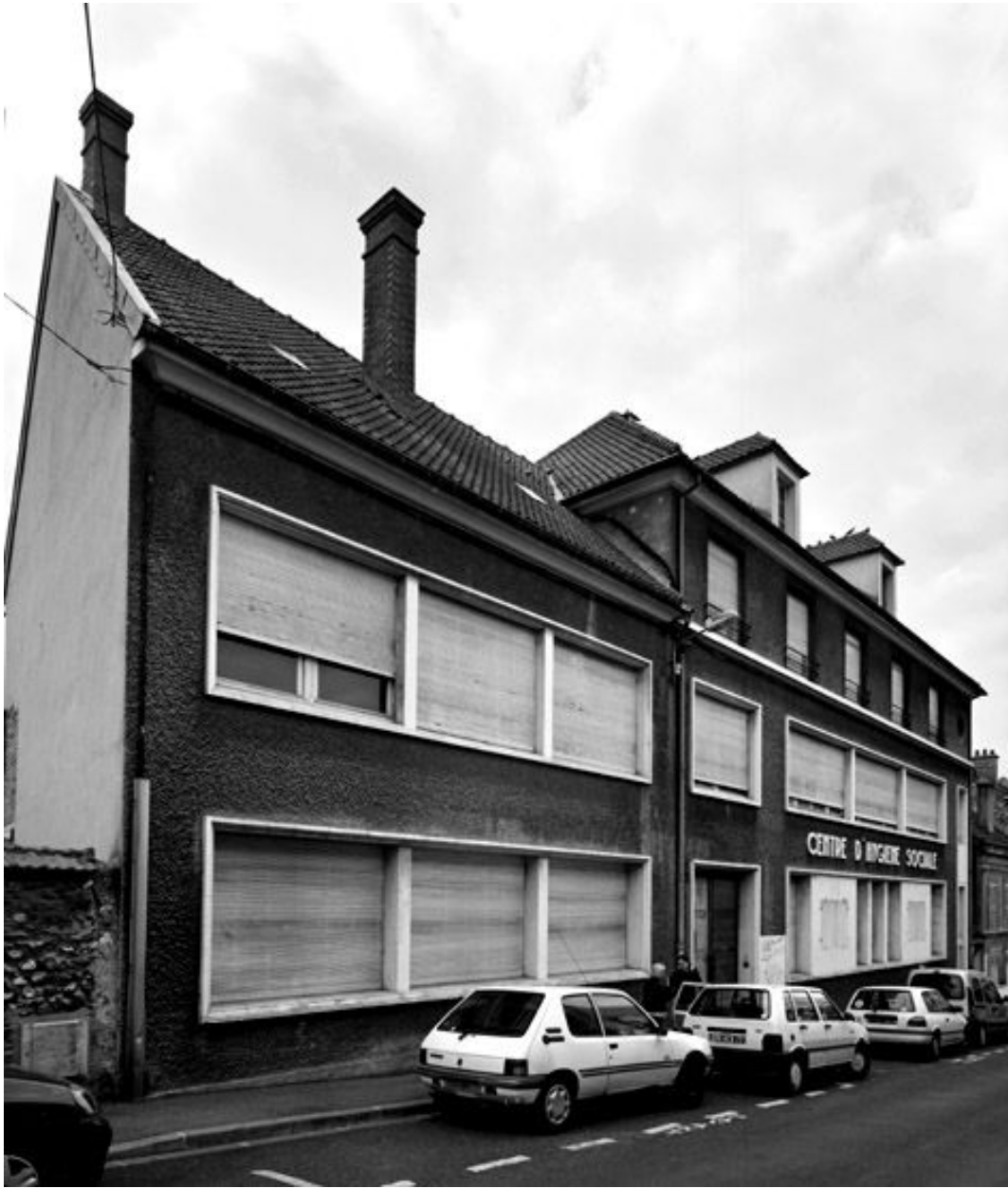
Le Centre d'hygiène sociale, rue Bontemps, photographié en 2003 avant sa destruction.
