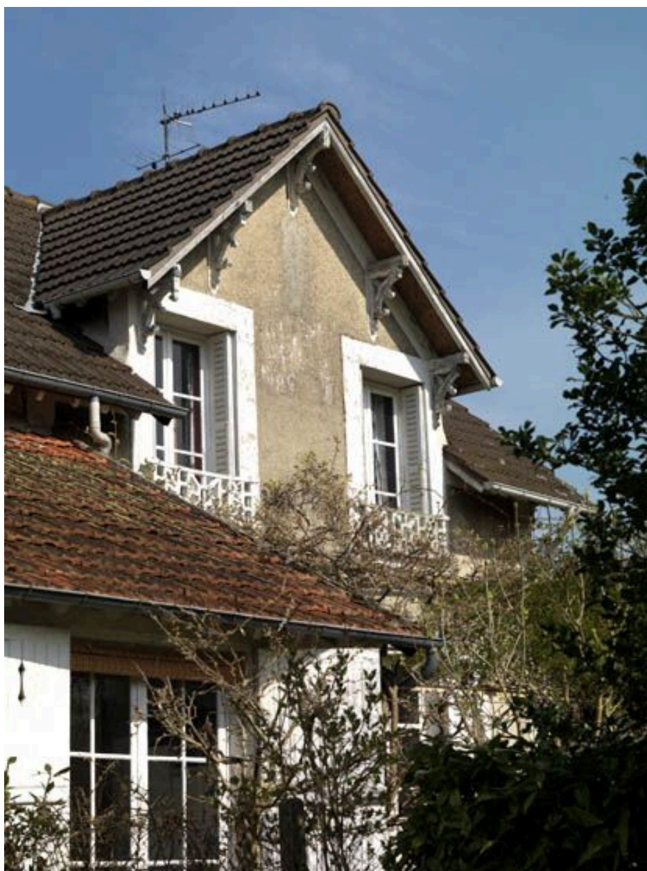
Façade arrière du logement du maître charpentier.
