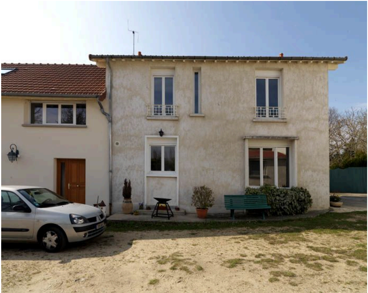
Façade sur cour du pavillon d'habitation.
