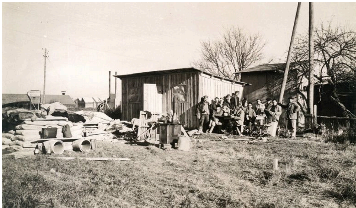
Vue du chantier du lotissement concerté dit Castors de La Pipée, au moment de la pose déjeuner, rue de la Pipée. Photographie, 1959. (Collection particulière)
