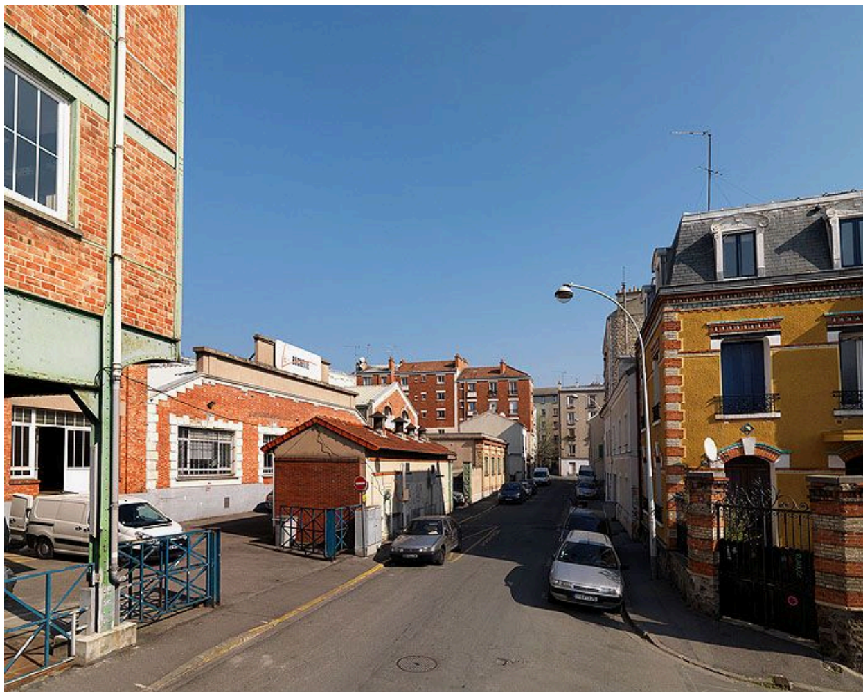
93, Bagnole, biscuiterie Belin , 15-17 rue Charles-Graindorge. Vue perspective des façades des locaux de production et de leur environnement urbain.
