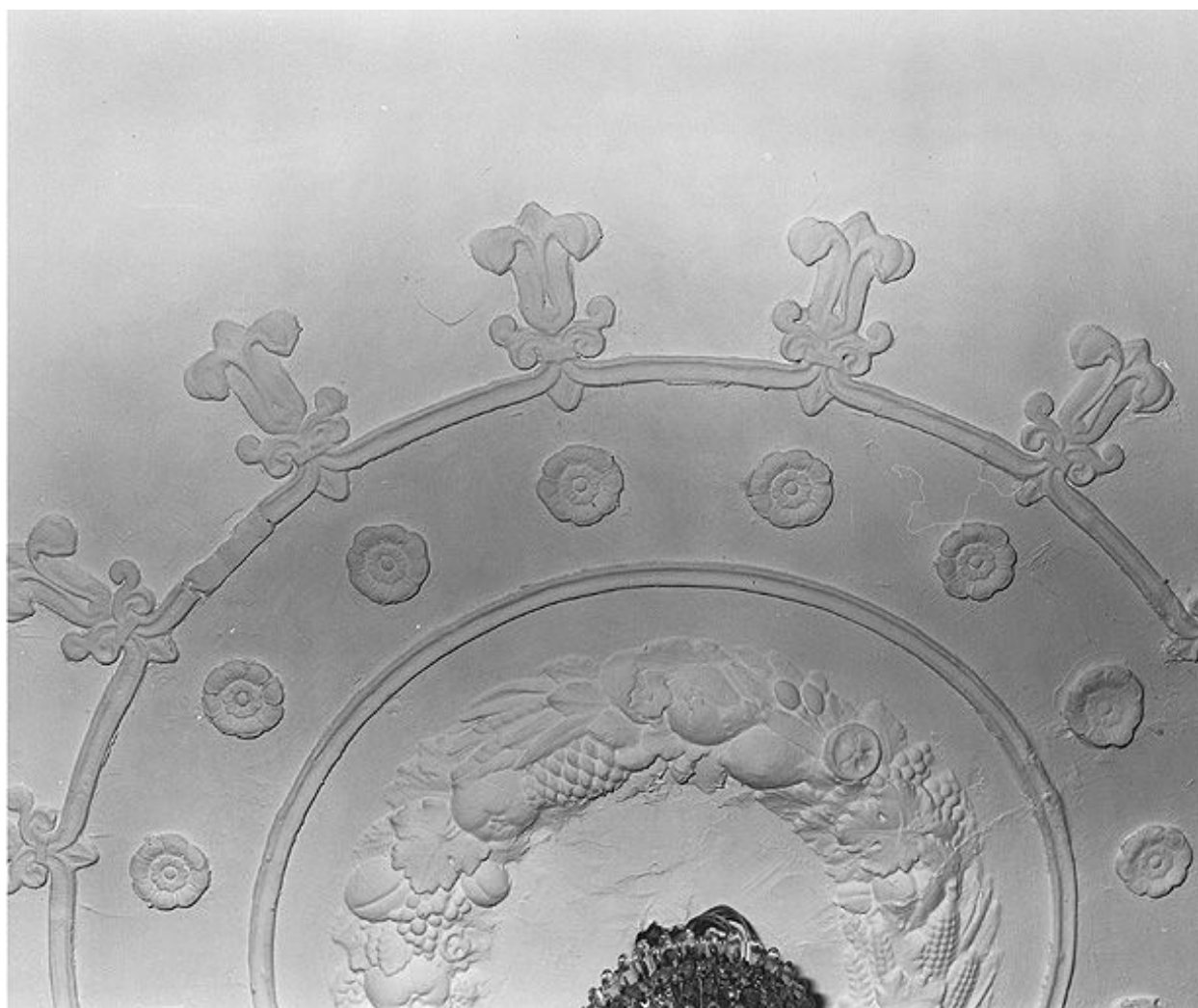
Détail d'un plafond au rez-de-chaussée.
