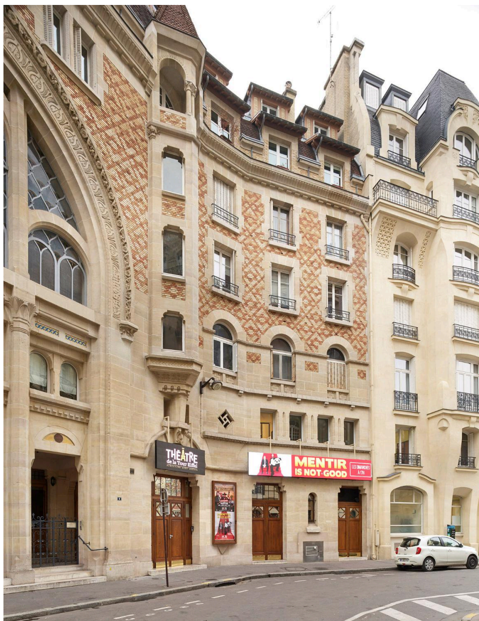
Façade, travées latérales comprenant l'entrée de la salle Adyar (actuel théâtre de la Tour Eiffel)
