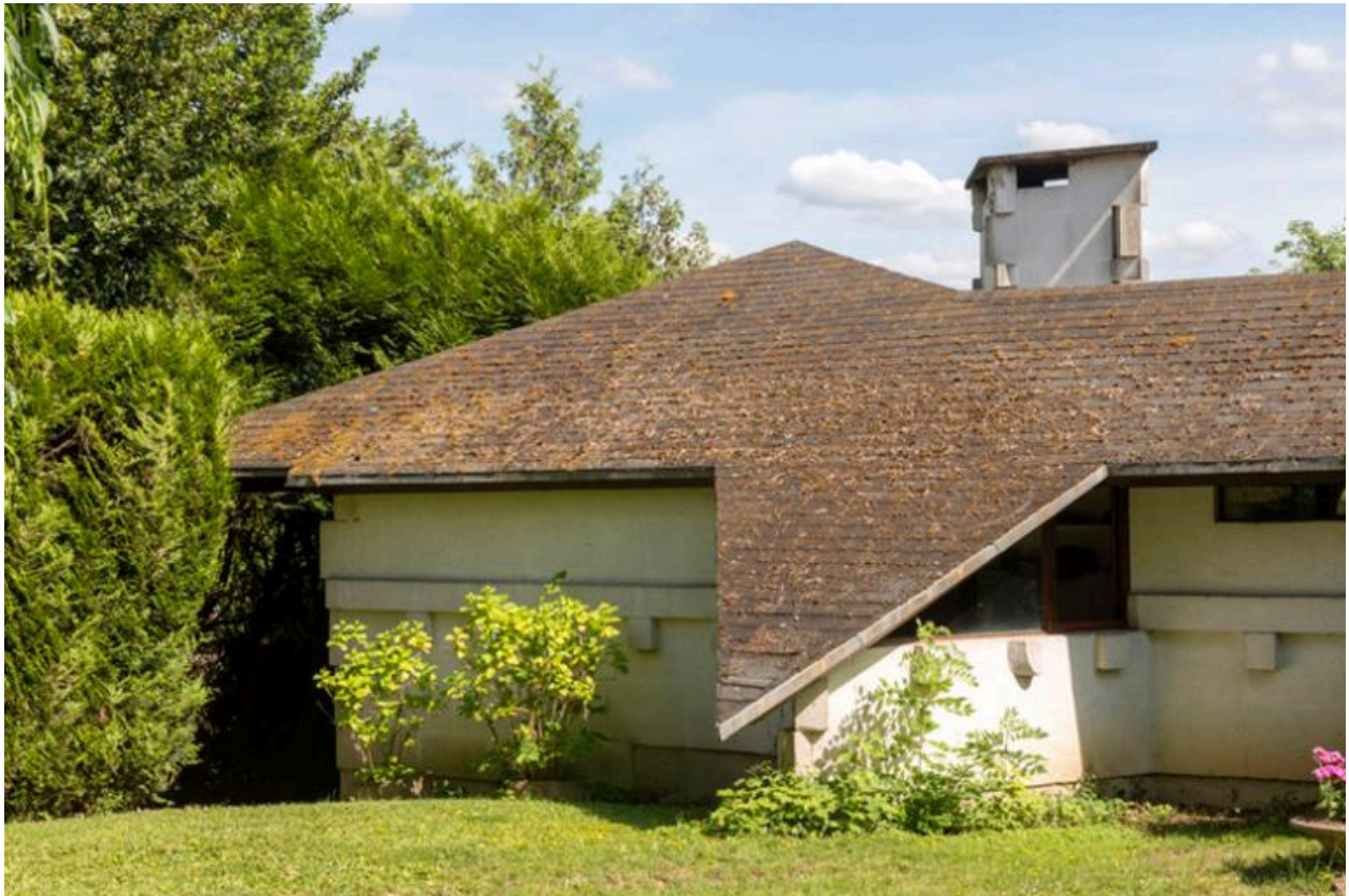
Vue rapprochée de la toiture de la façade postérieure.
