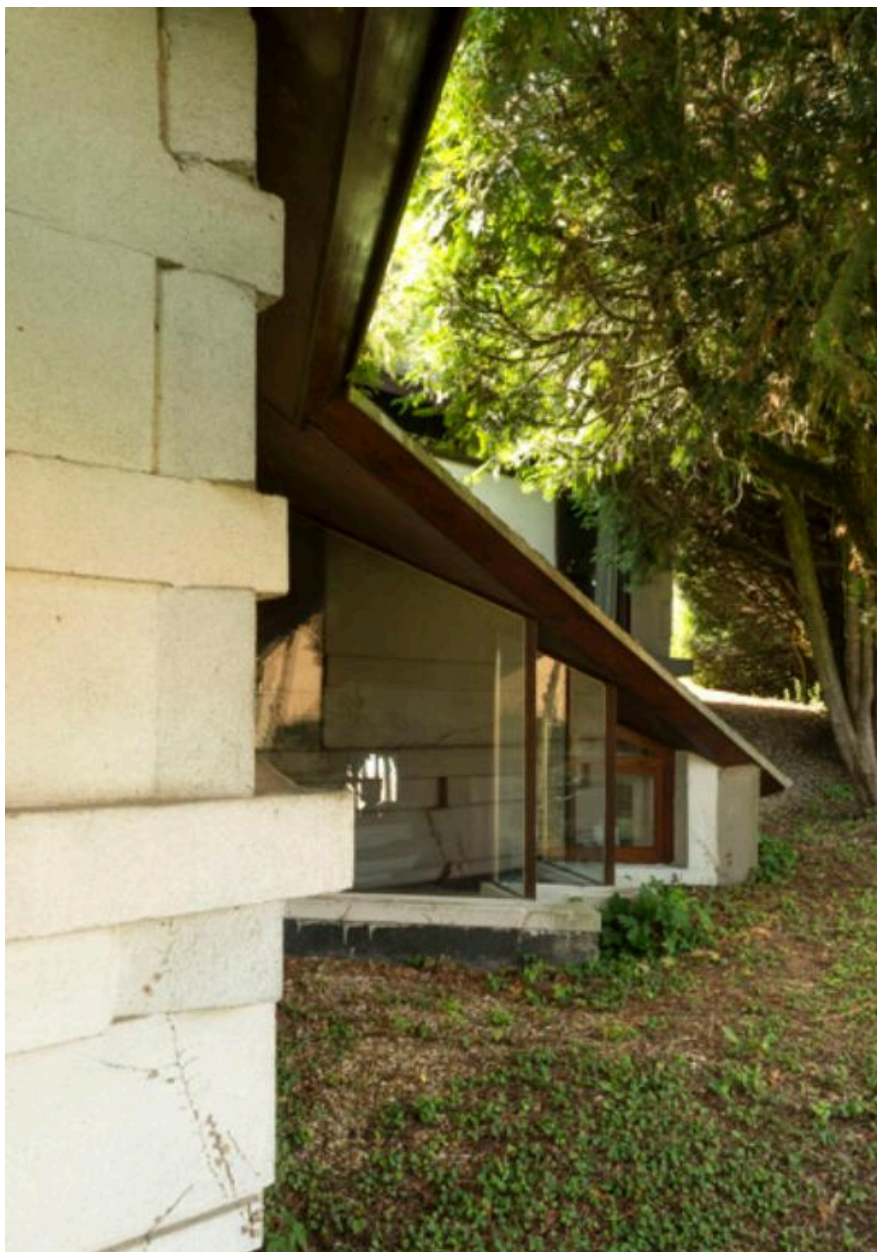
Vue de la façade latérale (côté droit).
