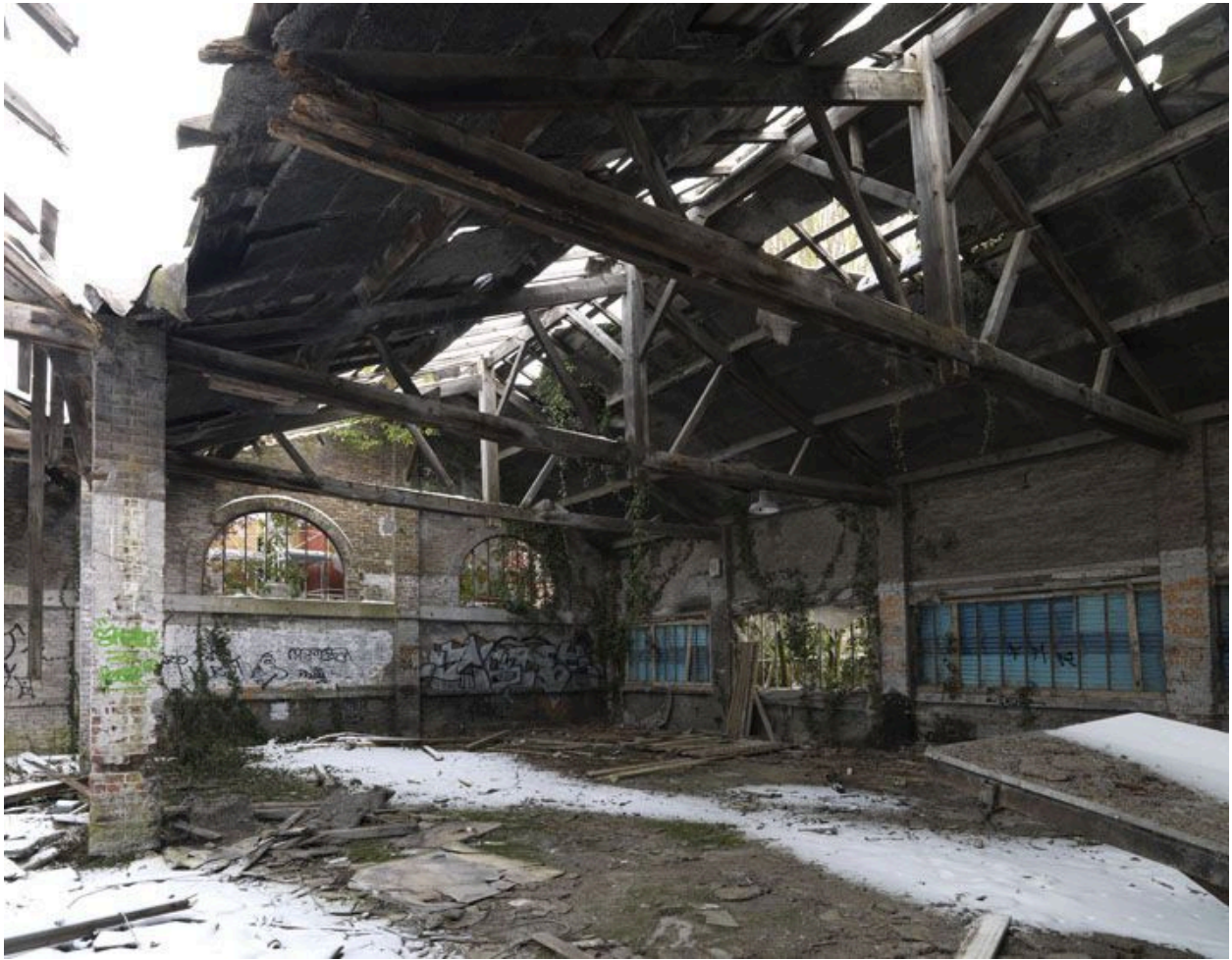
Follainville-Dennemont, cimenterie E. Candlot et Cie, puis A. Ladvocat et Cie , 44 rue Emile-Zola et rue Voltaire. Vestiges d'un atelier de préparation des matières premières.
