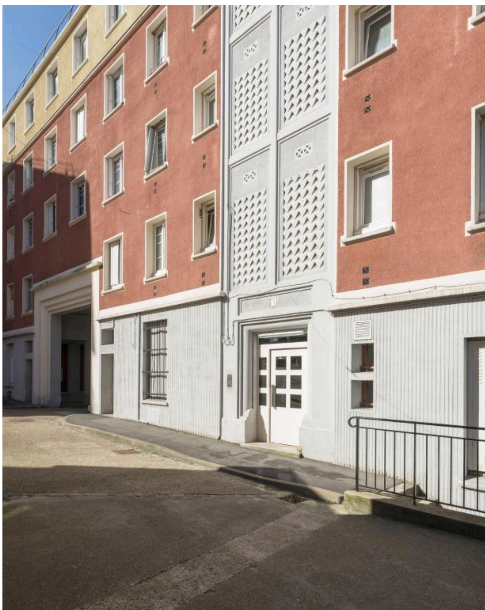
Vue de la façade du premier bâtiment côté cour (2)
