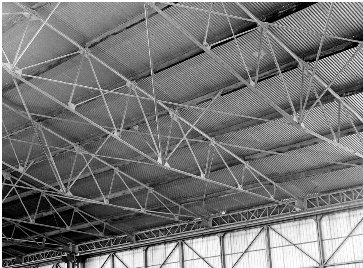
Détail des fermes métalliques.
