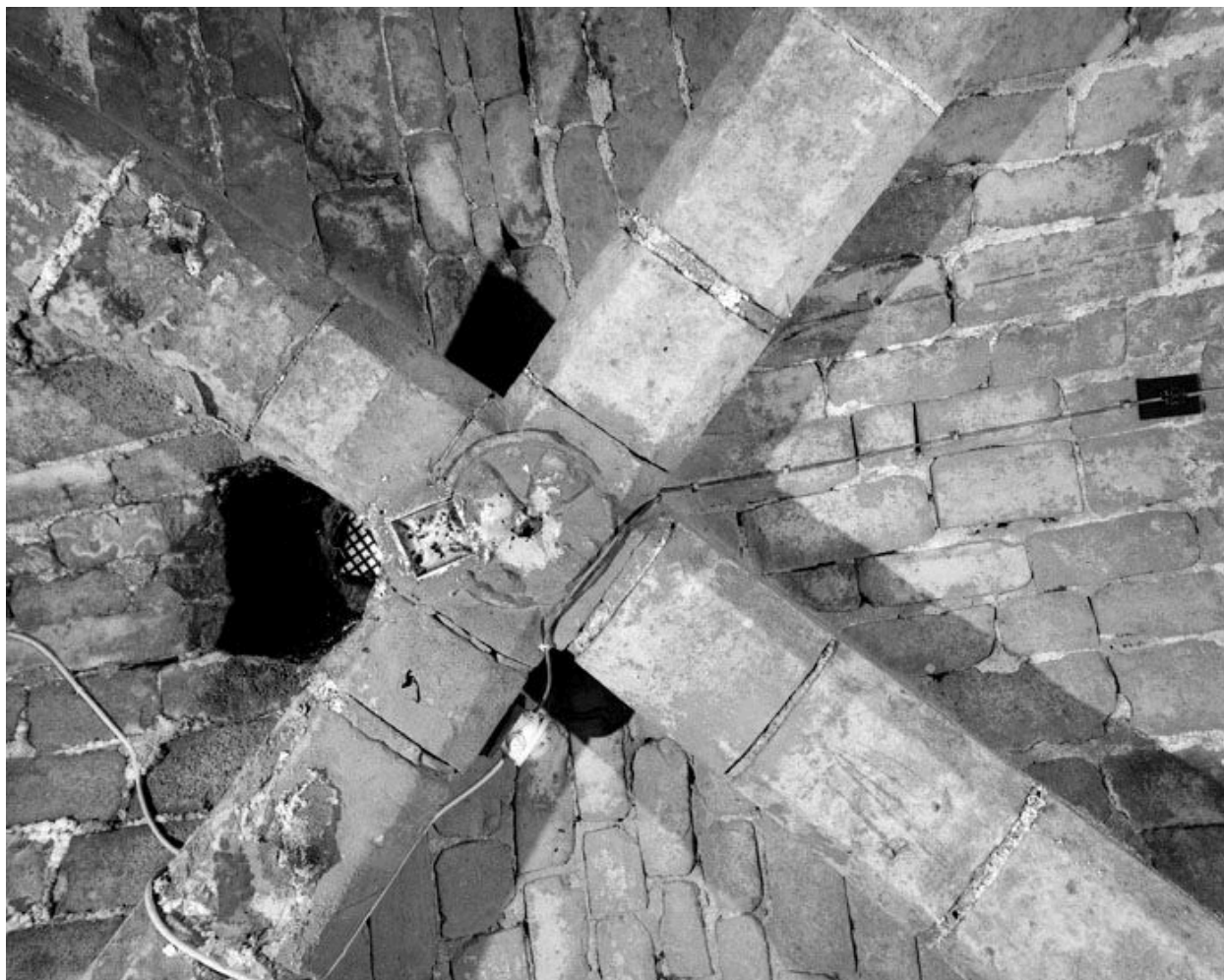
Cellier gothique : la croisée d'ogives centrale.
