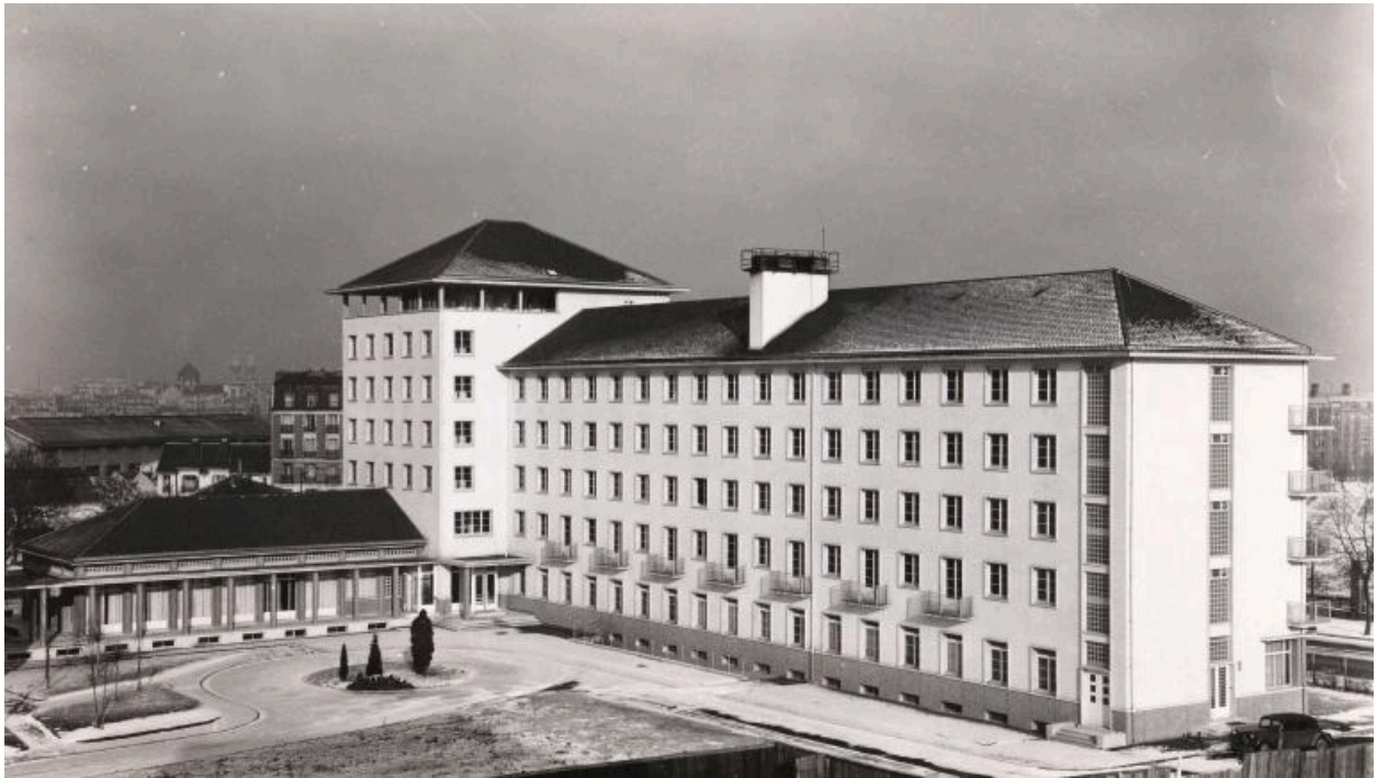
Le bâtiment de la Résidence générale et la galerie de liaison (accolée à la salle de réunion), côté est, vers 1955. Photographie. CIUP, centre de valorisation du patrimoine, P/TP-B34-11.06
