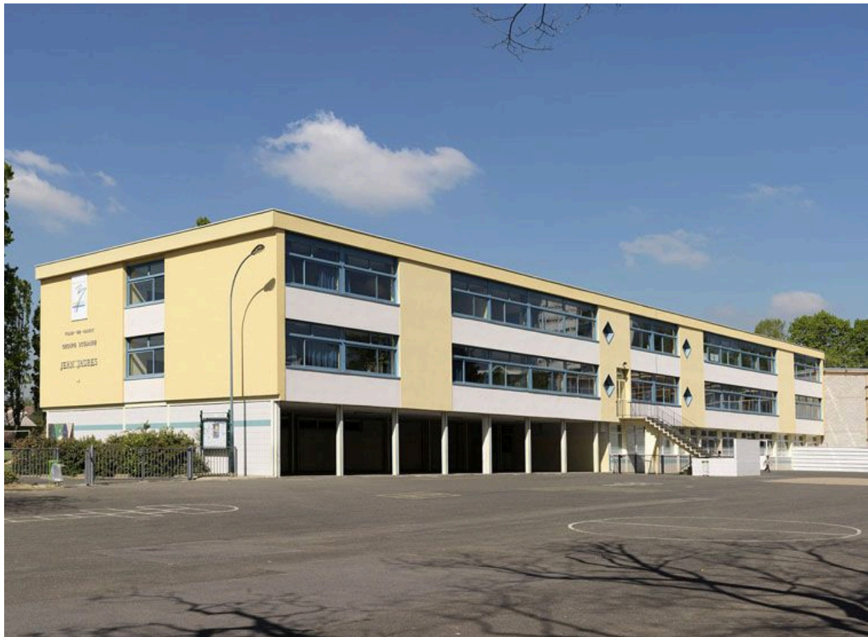
Groupe scolaire Jean Jaurès, 2 allée de Madrid. Vue générale.
