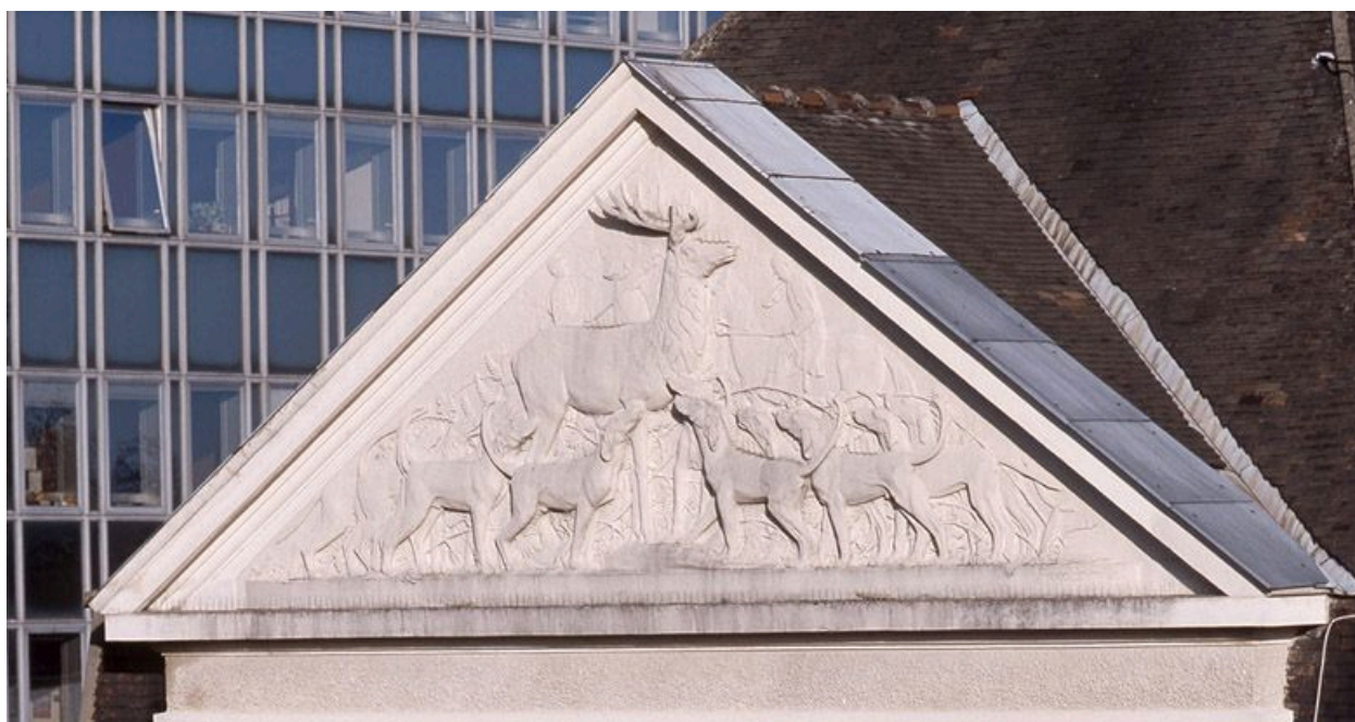
Bas-relief de Pascal Boureille (1951), sur la façade sud du bâtiment des années 1950.
