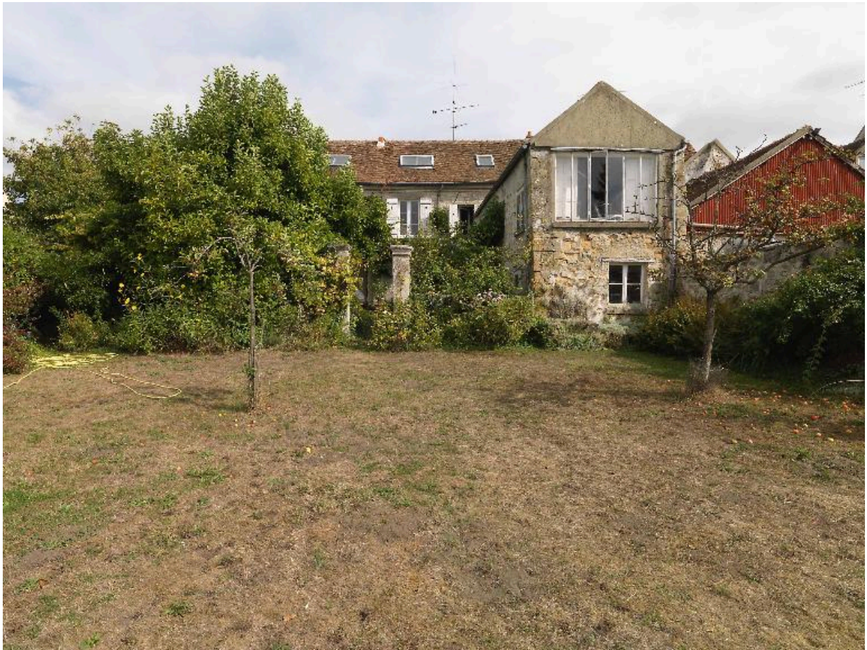
Vue éloignée de la façade postérieure et de la verrière de l'atelier
