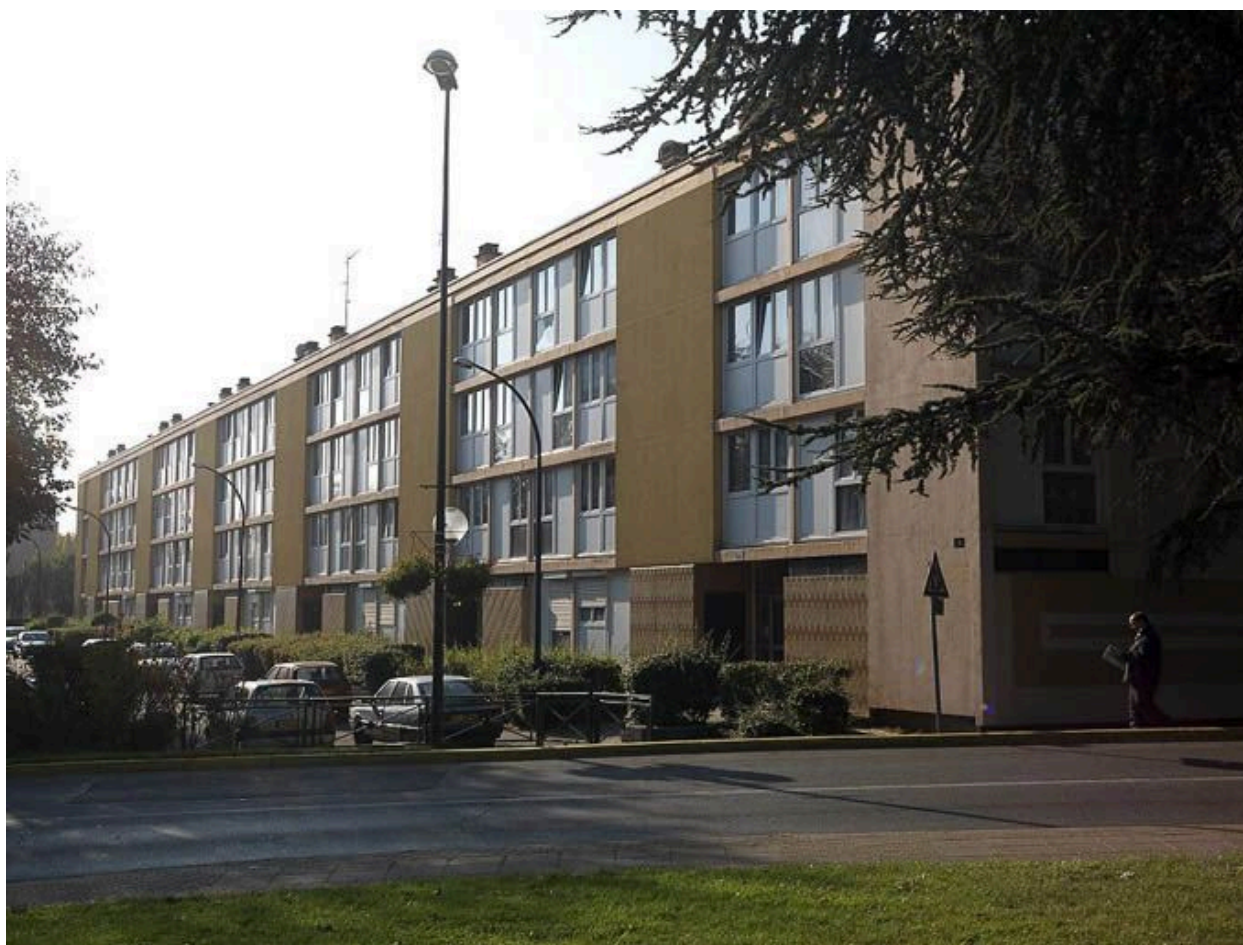
Un immeuble R+3 parallèle à la chaufferie, 2-12, avenue de la Concorde.
