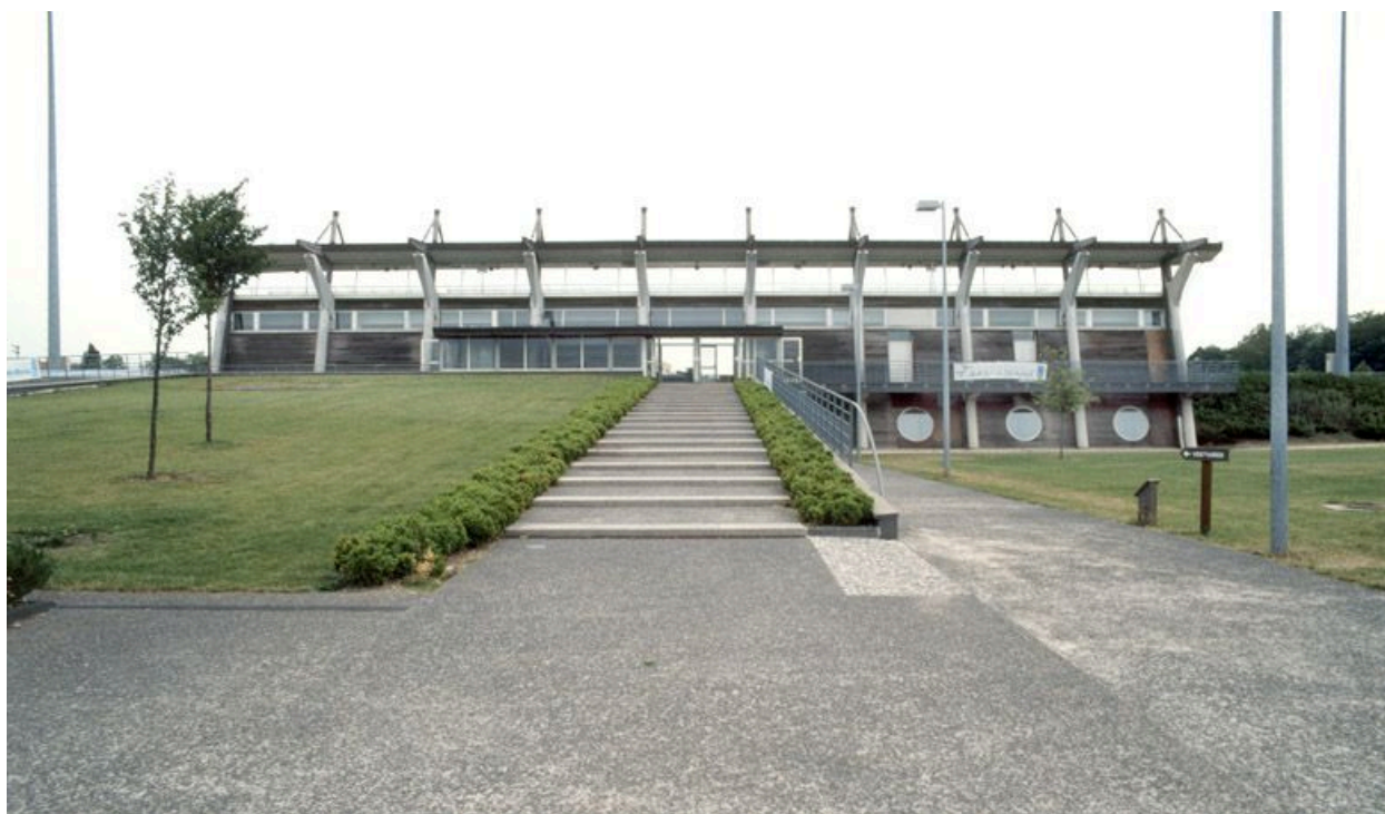
Stade des maisons rouges, 9 rue Clos Sainte Catherine. Vue d'ensemble du bâtiment des tribunes depuis le bas de la rampe d'accès.
